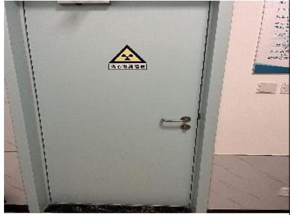
图 3-34 SPECT/CT 控制室防护门
