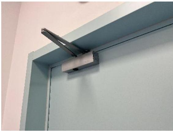
图 3-52 PET/CT 平开门自动闭门装置
